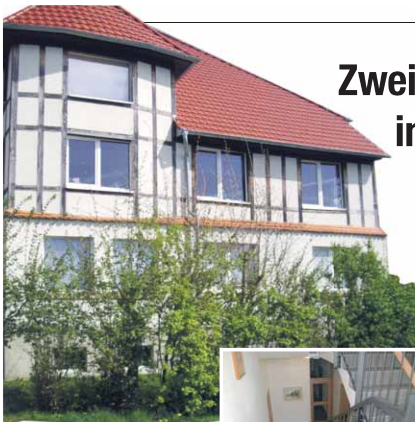
Das Schullandheim in Burk wurde renoviert.
