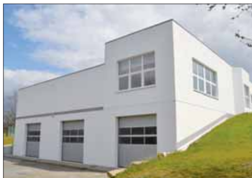
Der Anbau des Autohauses Krenz.
