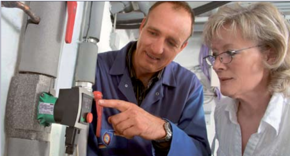
Pflege muss sein. Ein vernachlässigter Heizkessel kann bis zu zehn Prozent mehr Energie verbrauchen.
