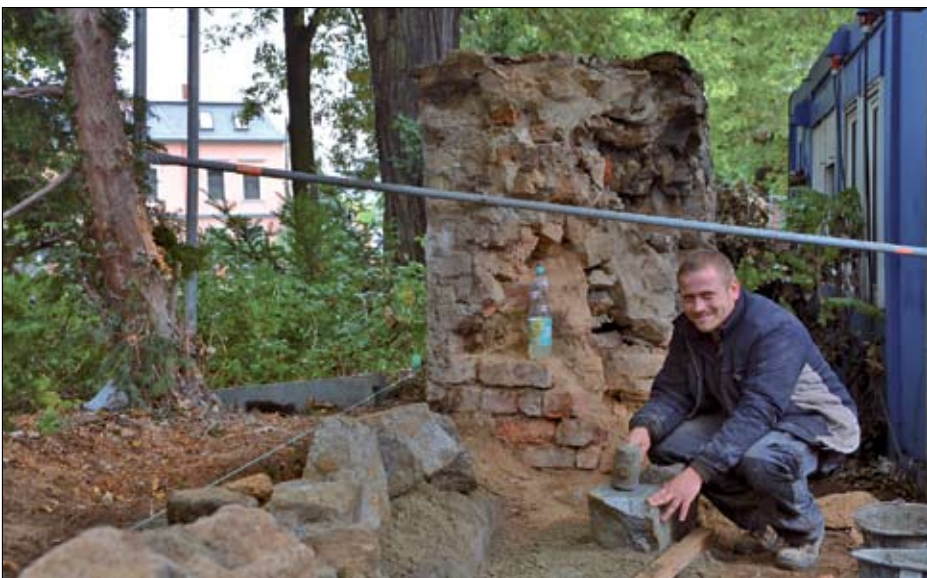
Stadtmauer mit integriertem Café-Pavillon
